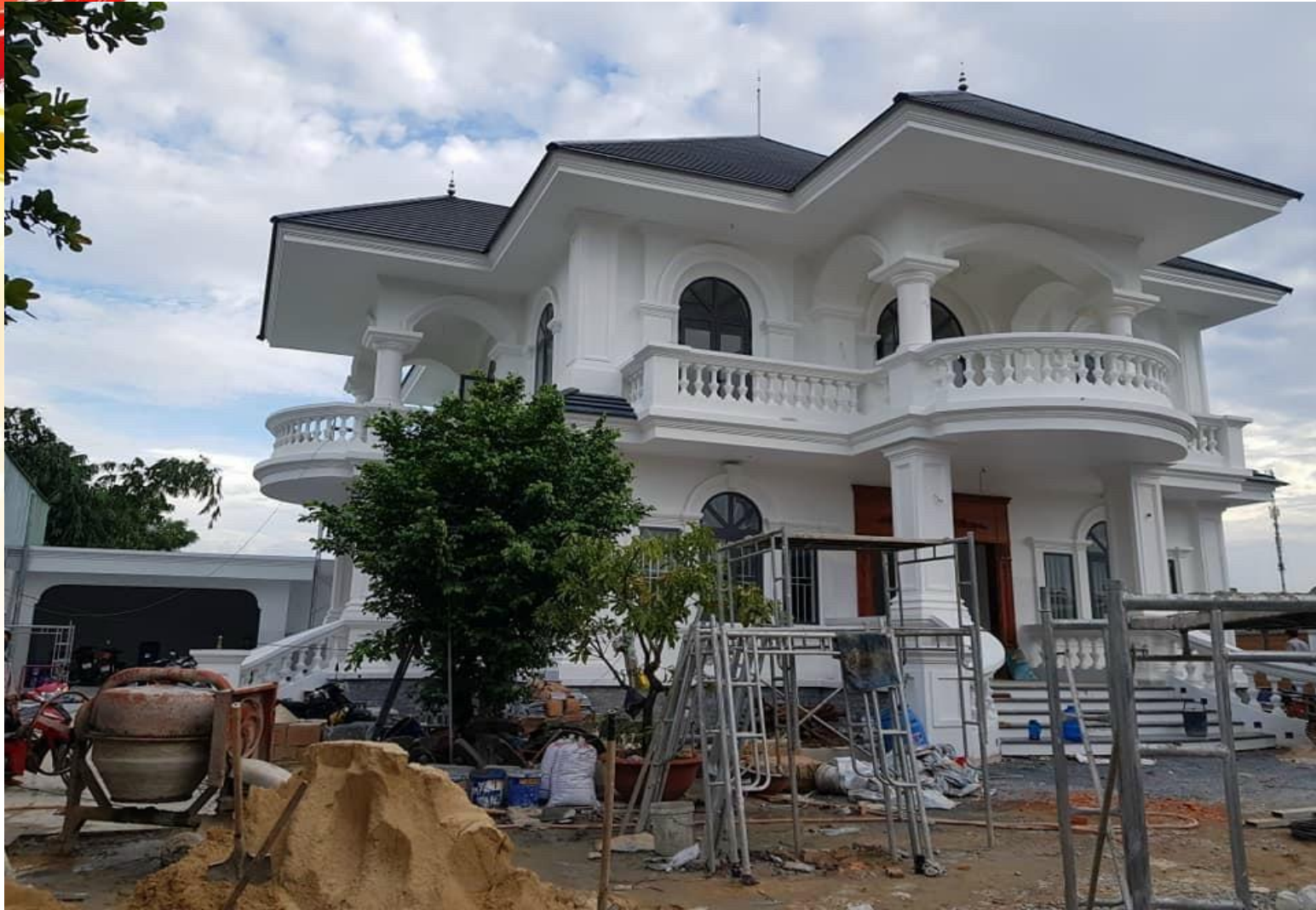
Dự án Phối màu, thi công Sơn nước Biệt thự Hoàng Phong Phú Hòa– Bình Dương
